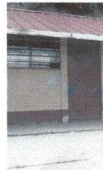
Foto 6: Puerta con chapas deterioradas.
