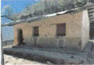
Foto 1: Techo de lamina deteriorada existente anteriormente.
